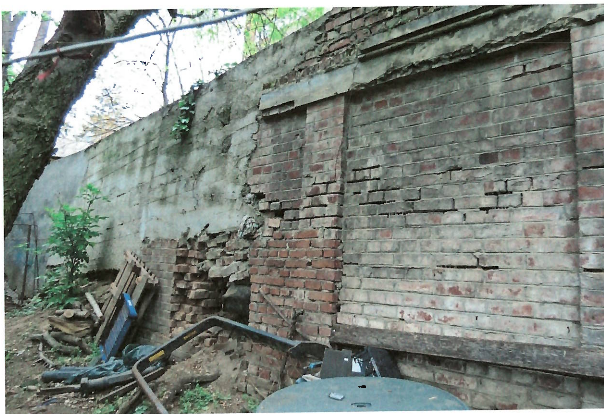
Figura 1. Gard in zona administrativa
