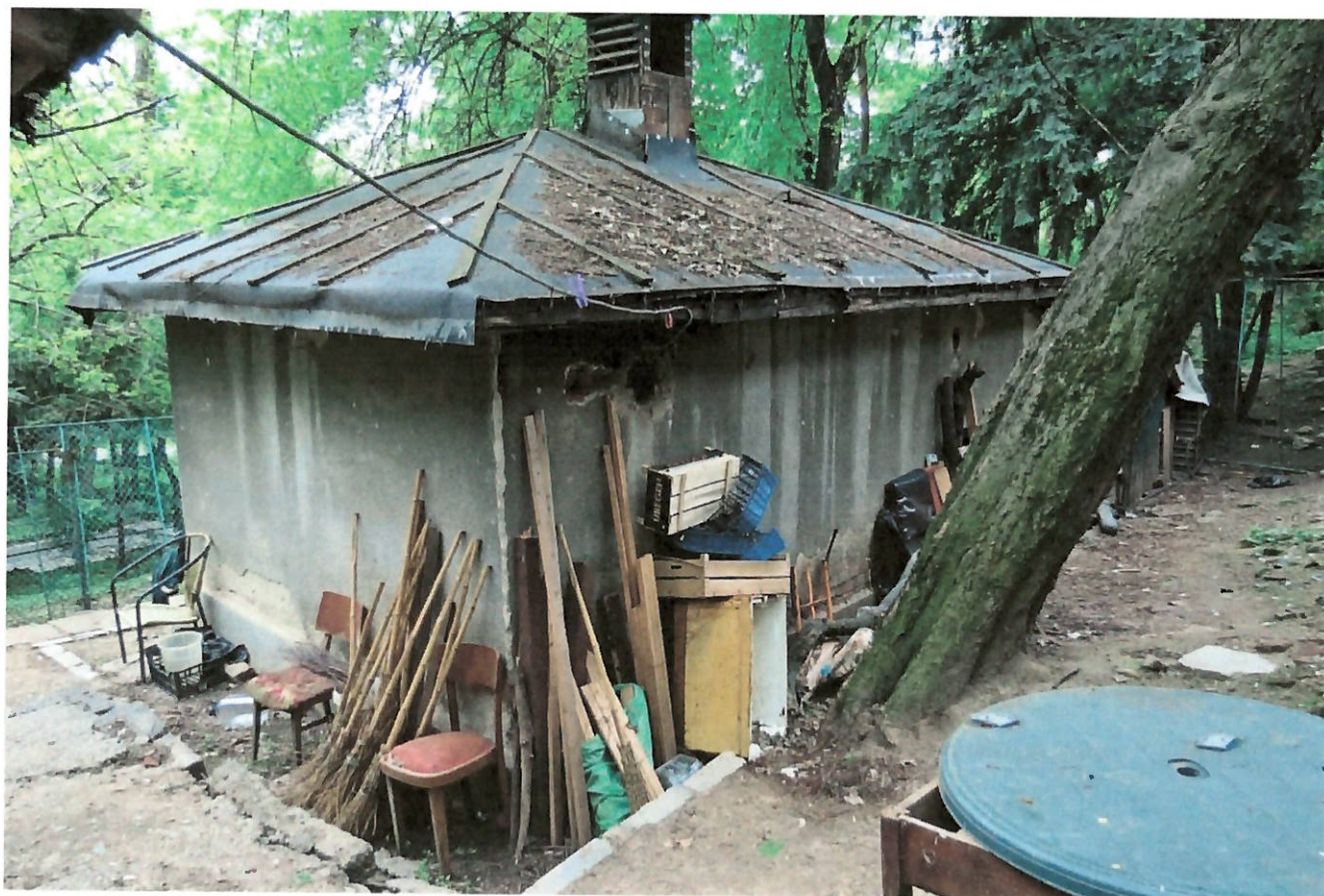
Figura 6. Clădire de birouri 1 - vedere de ansamblu
