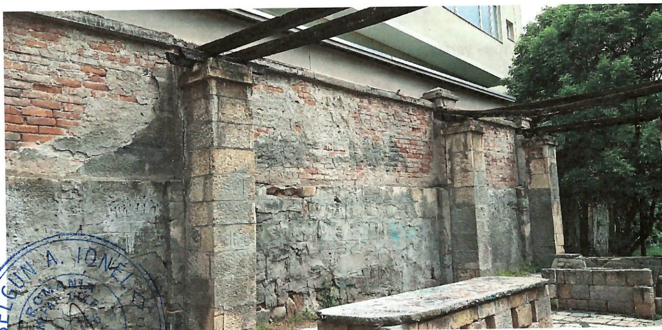
Figura 2. Zid de sprijin/gard in zona terasa trandafirilor
