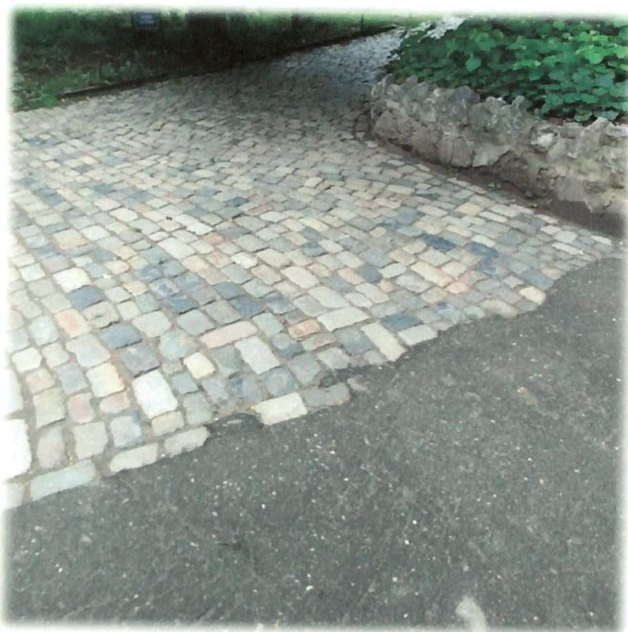
Zona imbinare cale pietonala asphalt - pavaj piatra (suprafete neregulate)
