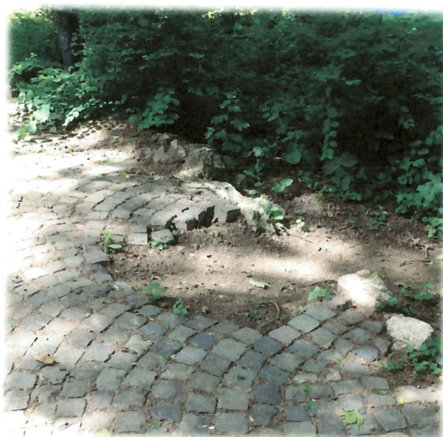
Zona cale pietonala - pavaj piatra (elemente lipsa, suprafata neregulata, tasari)
