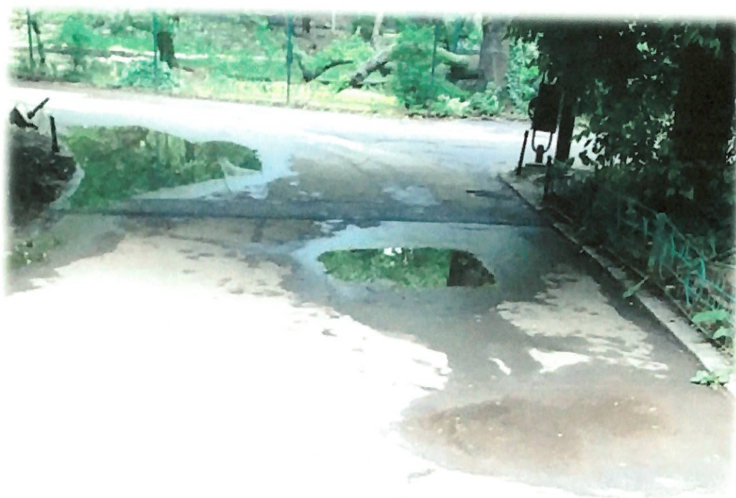
Stare generala asfalt degradata - faiantari, exfolieri, gropi
