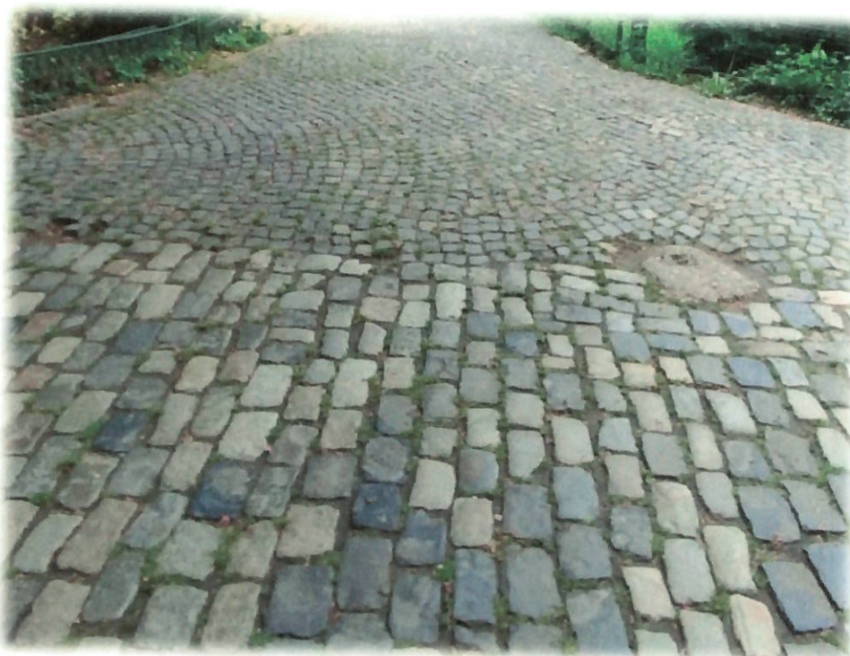
Zona imbinare cale pietonala piatra cubica - pavaj piatra (suprafete neregulate)
