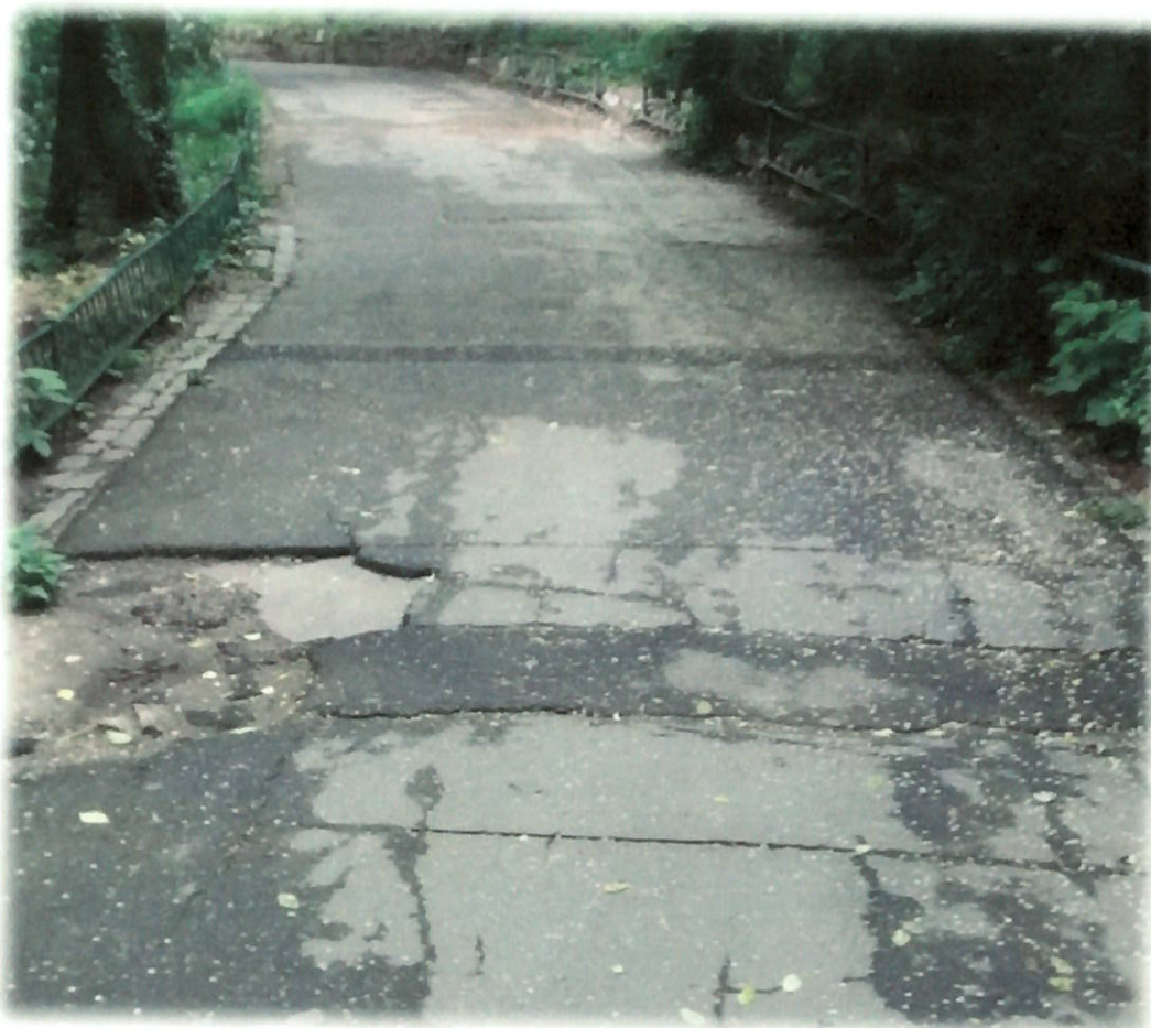
Stare generala asfalt degradata - faiantari, exfolieri, gropi
