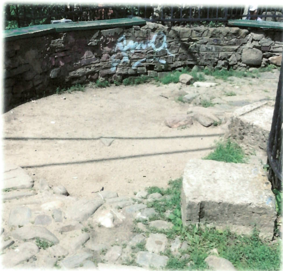
Zona cale pietonala - pavaj piatra (elemente lipsa, suprafata neregulata, tasari)
