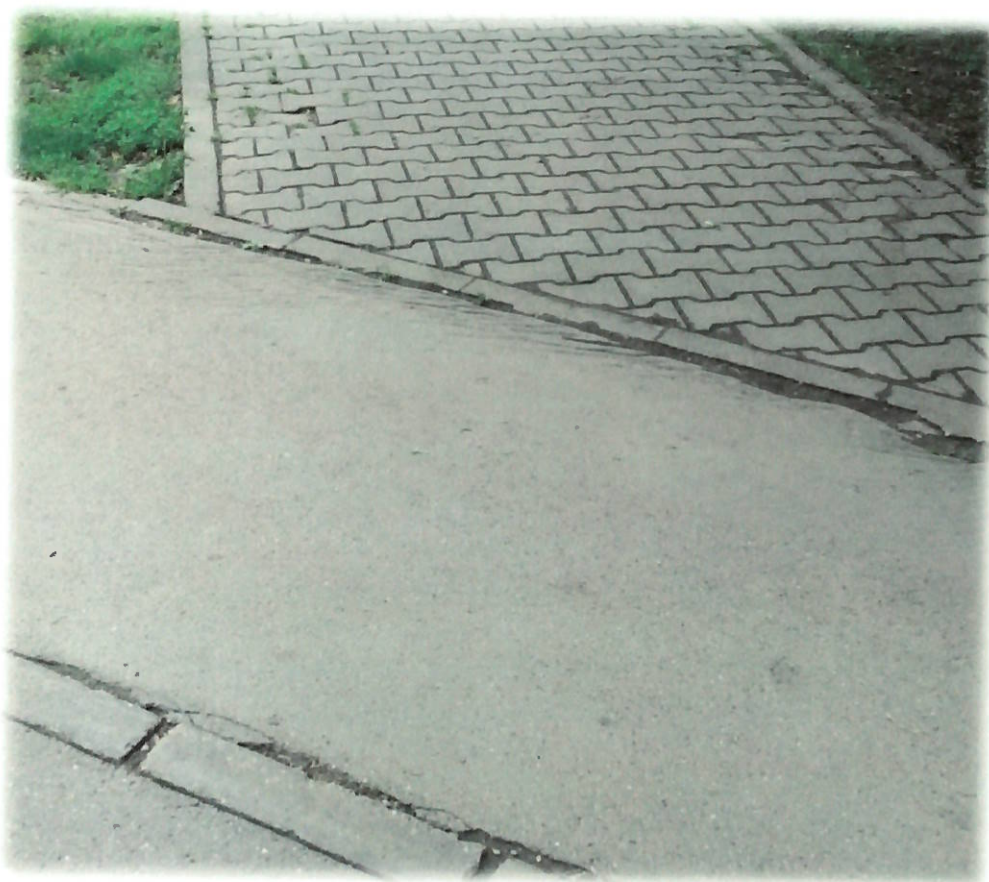
Zona imbinare cale pietonala asfalt - pavaj pavele autoblocante
