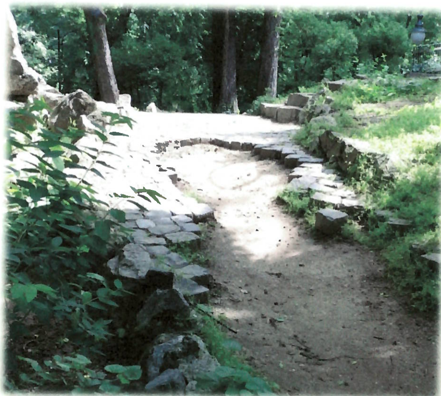
Zona cale pietonala - pavaj piatra (elemente lipsa, suprafata neregulata, tasari)
