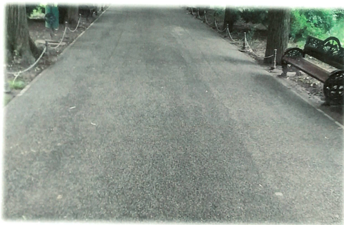
Stare generala asfalt buna - lungime cca. 120 m
